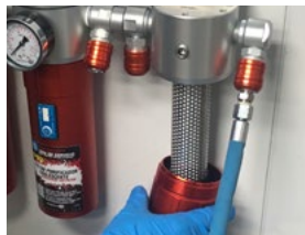
Desmonte o depósito
