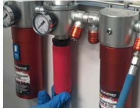
Entnehmen Sie den verbrauchten Filter
