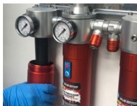
Desmonte o depósito
